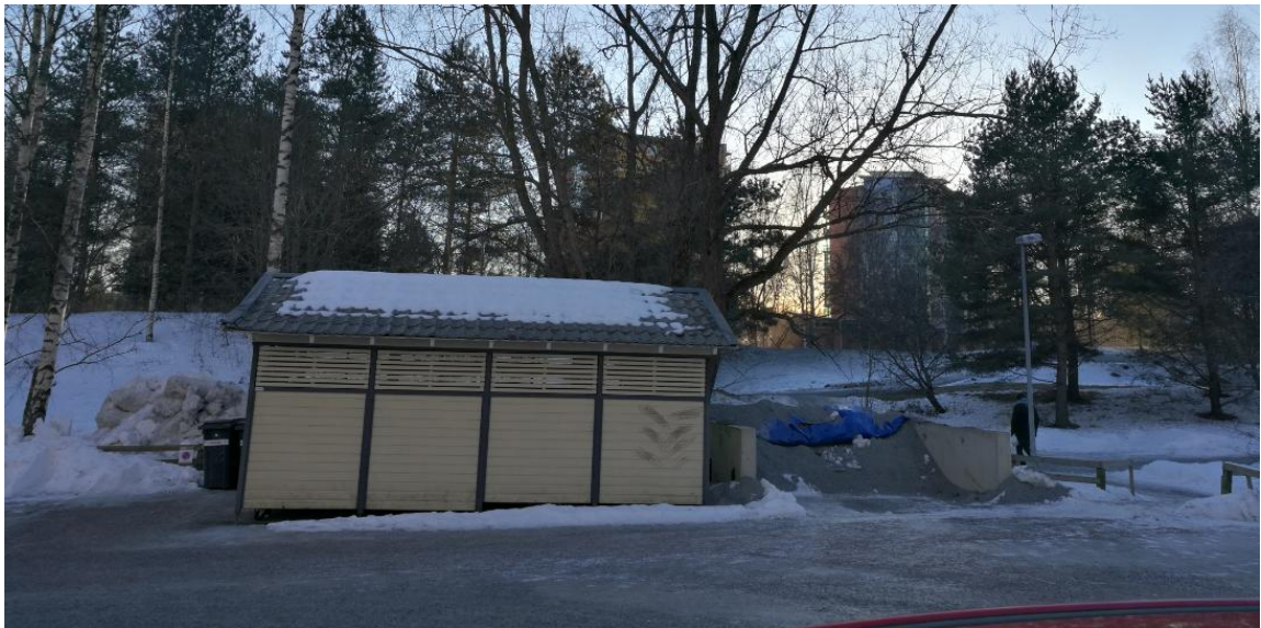
Kuva 3. Korvattavaksi ehdotettu kevytrakenteinen ulkorakennus
