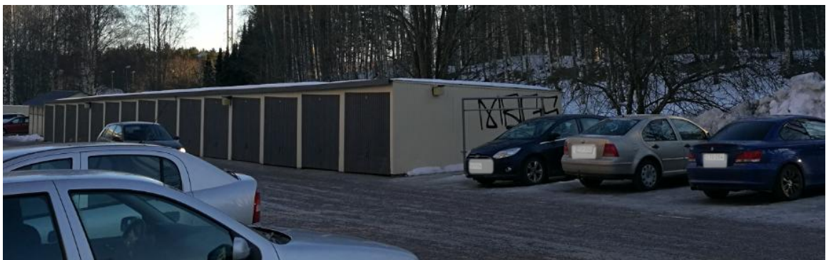
Kuva 4. Korotettavaksi ehdotettu autotallirakennus
